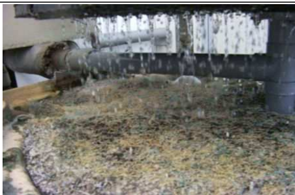
洗浄後は、フィルターが白くなり、藻も除去できている。
