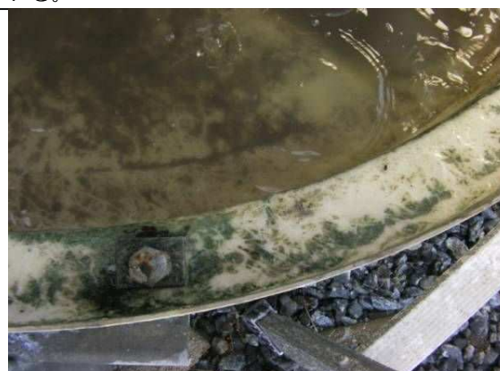
底が確認できるようになる。側面も洗浄できている。
