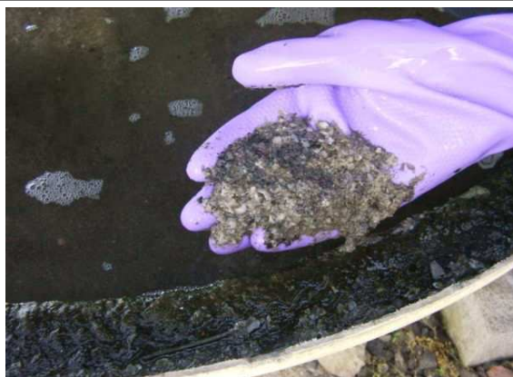
フィルター下にスケールがたっぷり。底が見えない。レジオネラ菌も繁殖していると推定される。
