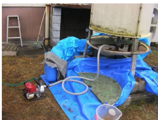
給水ポンプで吸い取っている画像 ↑
