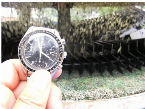
ズロンPHをクーリングタワーに 投入後の画像 ↑
