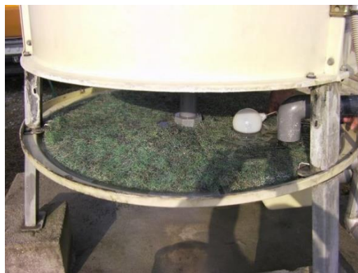
クーリングタワー施工終了画像 ↑
