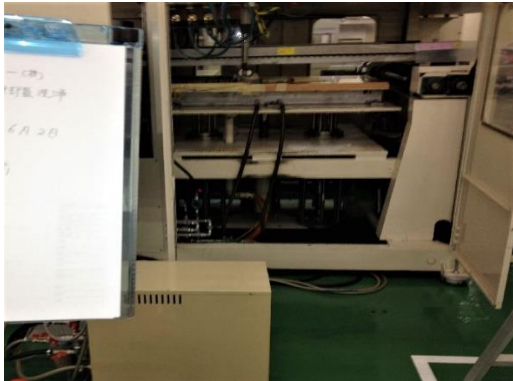
金型成型機、施工前の画像 ↑
