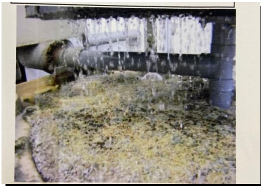
ゾロンSSSで施工中の画像 ↑
