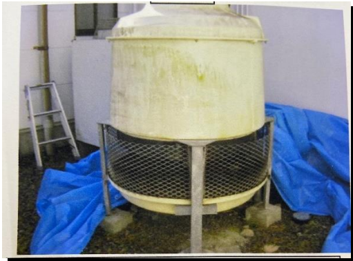
クーリングタワー施工前の画像
