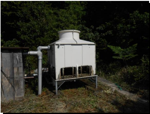
クーリングタワー施工前の画像
