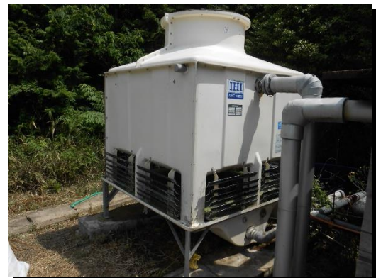
クーリングタワー施工終了の画像
